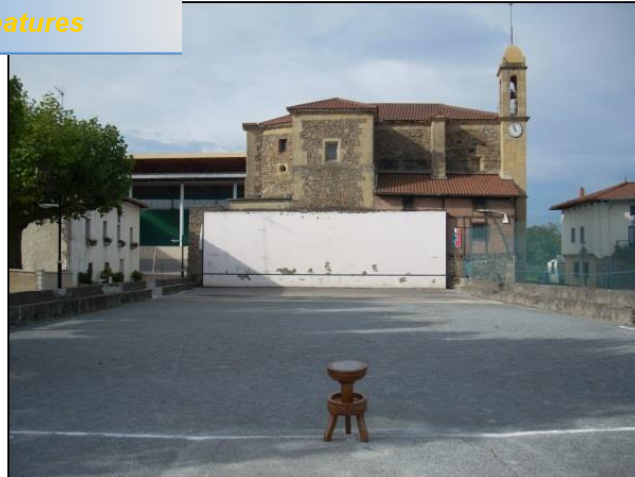
Figura 8. Plaza de Rebote de Zubieta (Gipuzkoa). (Fuente: Oidui Usabiaga)
